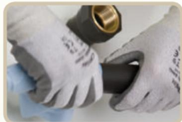
**Pulire le parti da incollare**, prima l'interno del raccordo e, quindi, il tubo con il decappante Cleaner+. Utilizzare un panno pulito. Lasciare asciugare o asciugare con l'aiuto di un panno morbido.
