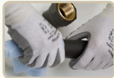
**Nettoyer les parties à encoller** Femelle puis Mâle avec le décapant Cleaner+. Utiliser un chiffon propre. Laisser sécher ou sécher à l'aide d'un chiffon doux.
