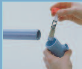
Lijm aanbrengen op zowel buis als fitting
