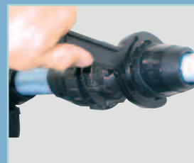
Met de speciale Quickair® sleutel of met een bandsphantang de wartel 1/4 slag aandraaien
