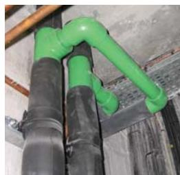
**GL :** Le Kryoclim est une solution économiquement avantageuse puisque les tubes n'ont pas besoin d'être peints et on utilise beaucoup moins de calorifuges qu'avec des réseaux en acier et la pose est plus rapide.
